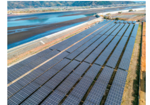
▲ サンテックパワー・ジャパン熊本太陽光発電所 建設工事
