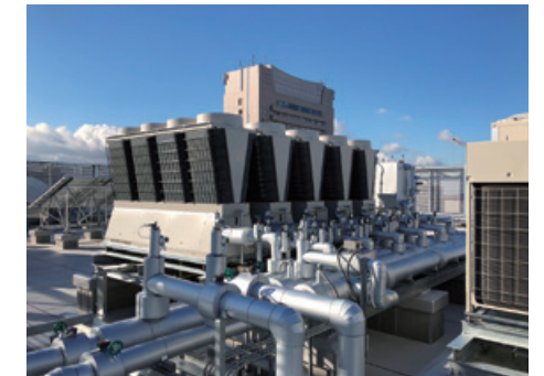
▲ 神戸市西区総合庁舎 空調設備工事
