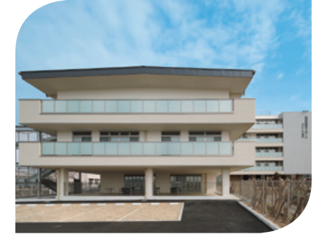
▲ 特別養護老人ホームオレンジ神戸 新築工事
