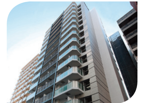
▲ 大阪市福島区福島6丁目 新築工事 (エスリード福島ラグジェ)
