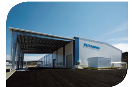
▲ (株)二川工業製作所 神戸工場 新築工事
