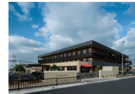
▲ 特別養護老人ホームくみのき苑しらさぎ 新築工事
