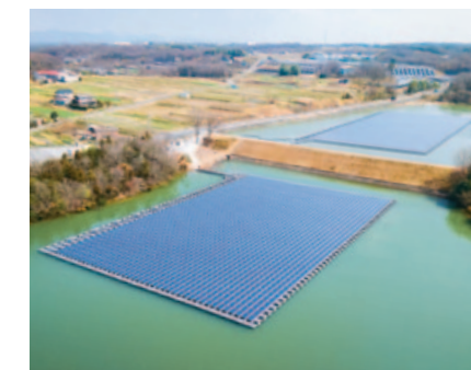
▲ 亥ノ子池 水上太陽光発電所工事
