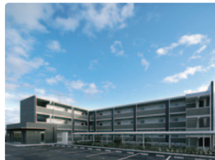
▲小東山北地区学生マンション 新築工事 (エス・キューパル小東台)
