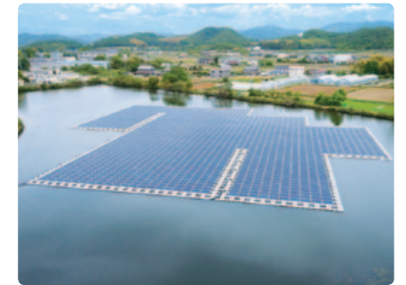
▲護持ヶ池 水上太陽光発電所工事
