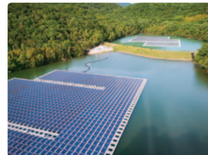
▲立会池・奥池 水上太陽光発電所工事
