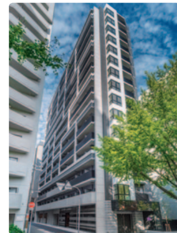
▲サムティ西区南堀江2丁目 新築工事 (S-RESIDENCE南堀江)
