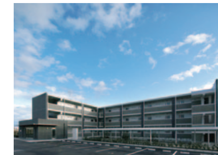
↑ 小東山北地区学生マンション 新築工事
