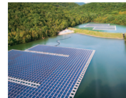
↑ 立会池・奥池 水上太陽光発電所工事
