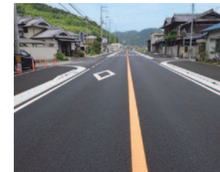
↑ (国) 372号交通安全 道路改良工事
