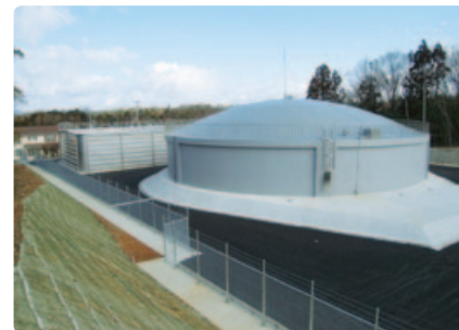
▲ 焼山配水池 改修工事
