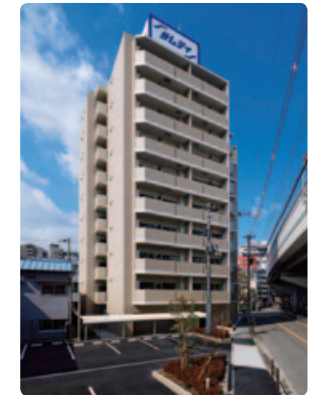
▲ サムティ福島区鷺洲4丁目 新築工事
