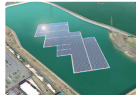
▲ 河原山池 水上太陽光発電所工事
