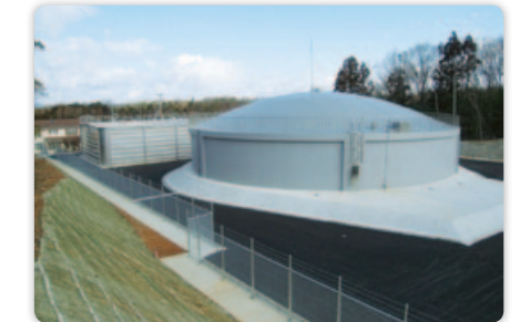
焼山配水池 改修工事
