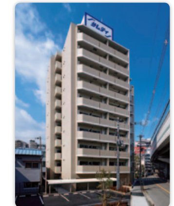
サムティ福島区鷺洲4丁目 新築工事
