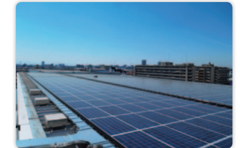
いちかわ倉庫(株) 太陽光発電所建設工事
