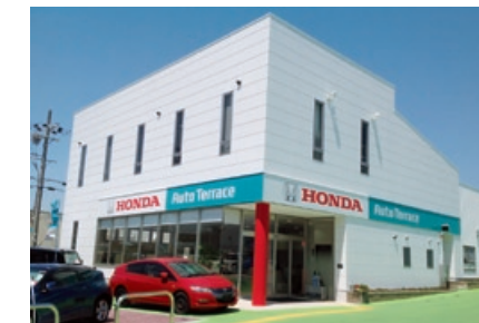
▲ オートテラス明石西 新築工事
