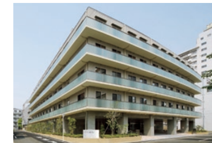
▲ 特別養護老人ホームザイオン新大阪 新築工事
