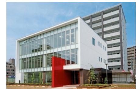
▲ 播磨リビング新聞社ビル 新築工事
