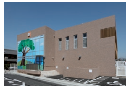
↑ かんまき和光保育園 新築工事
