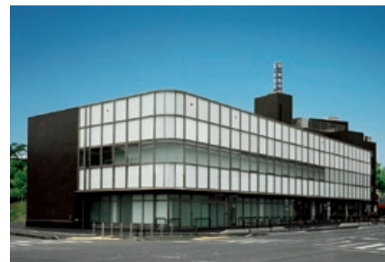
↑ 第一東和会病院 増改築工事
