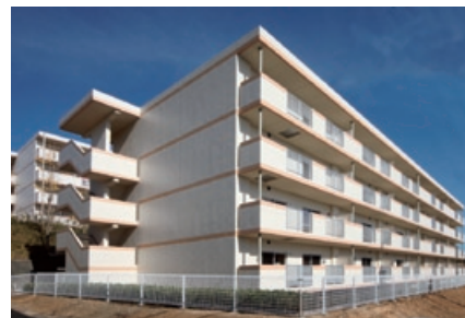
↑ 県営明石大久保住宅 第3期建築工事
