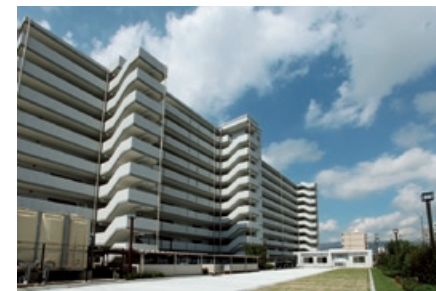
↑ 県営西宮今津住宅 第2期建築工事
