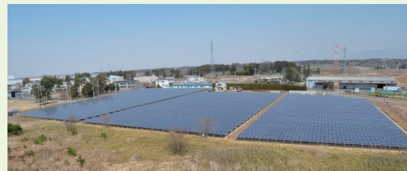
(美樹工業つくばメガソーラー発電所 全景)
