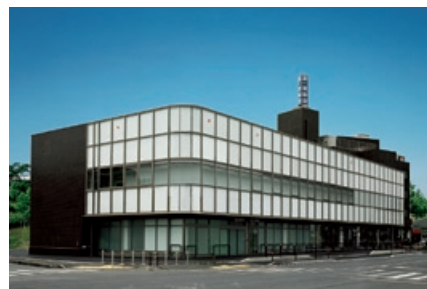
▲ 第一東和会病院 増改築工事
