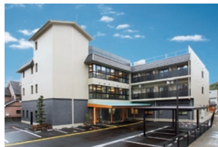
▲ ケアサービス神姫あおやま 新築工事
