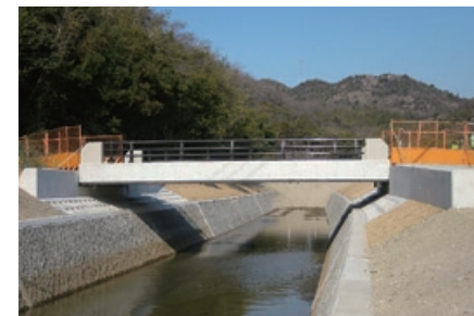
↑ 都市基盤河川大井川 改修工事
