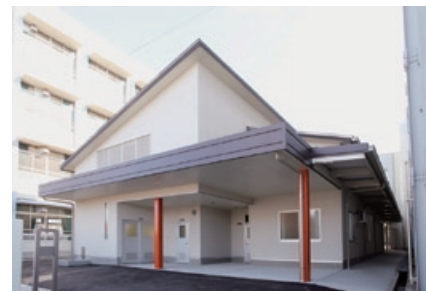
↑ 姫路市立東小学校給食室 改築工事
