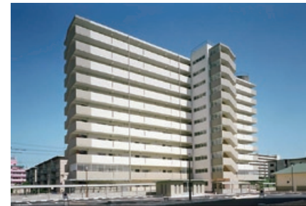
↑ 大阪府営高槻深沢第4期高層住宅 新築工事
