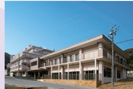
↑ 老人保健施設ハイマート 増築工事
