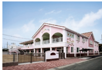
↑ 播磨保育園 改築工事
