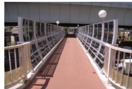
↑ 国道43号東本町西歩道橋 改良工事
