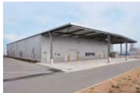
▲西島備蓄倉庫
