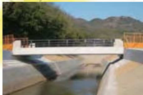
▲大井川 改修工事
