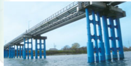
▲市川水管橋 耐震補強
