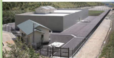
▲見津が丘特1高区配水池
