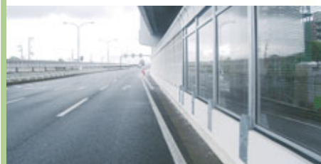
▲国道43号西宮維持出張所 管内遮音壁設置
