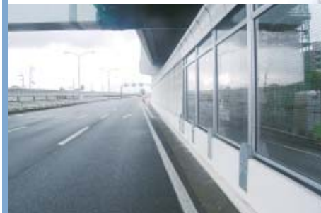
▲国道43号西宮維持出張所 管内遮音壁設置
