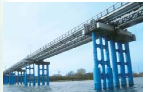
▲市川水管橋 耐震補強
