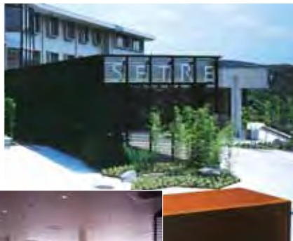
▲SETREハイランドプラザ姫路 外観
