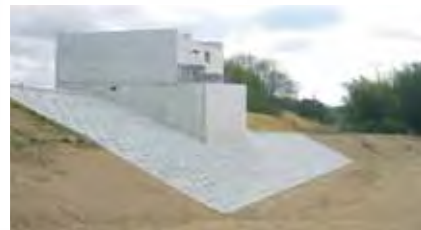
▲加東大橋下部工
