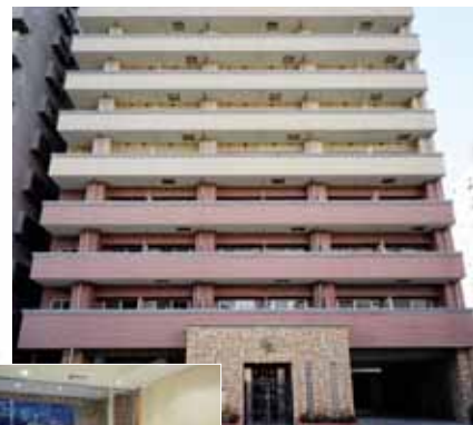
▲グランシス江坂マンション外観
