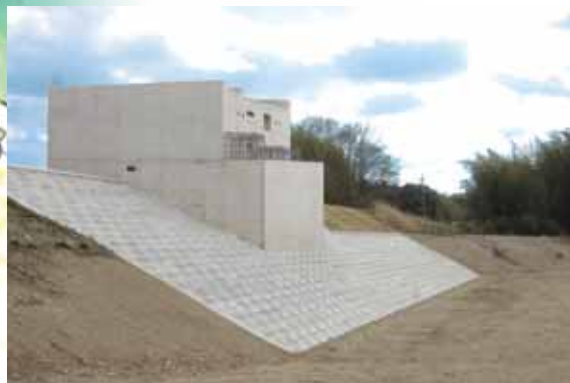
▲加東大橋下部工
